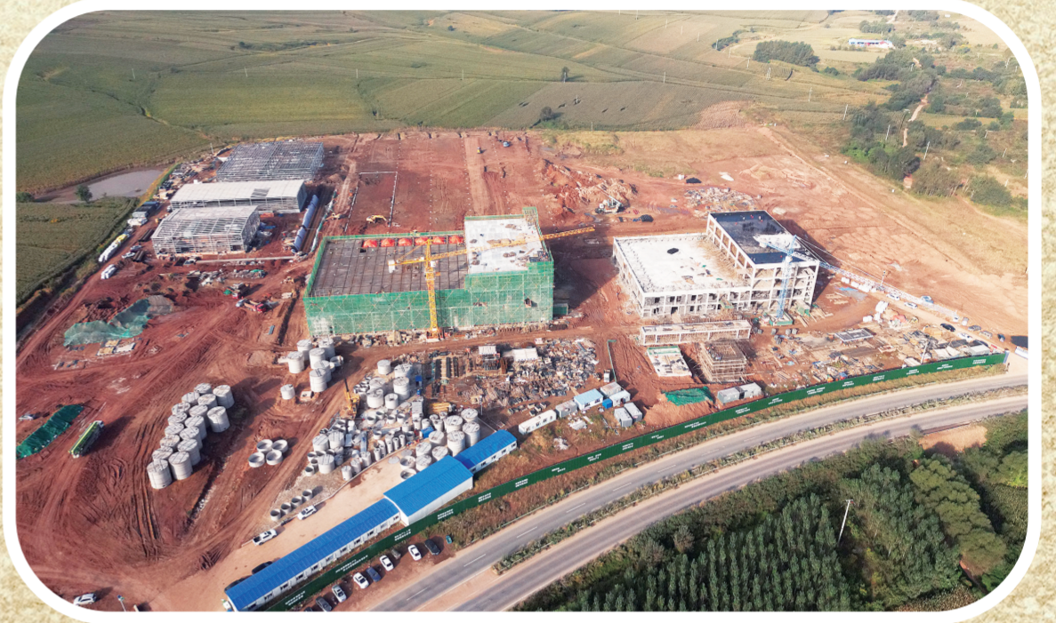
梨树县新开区化工园区的秸秆综合利用产业园建设项目。（资料图片）
