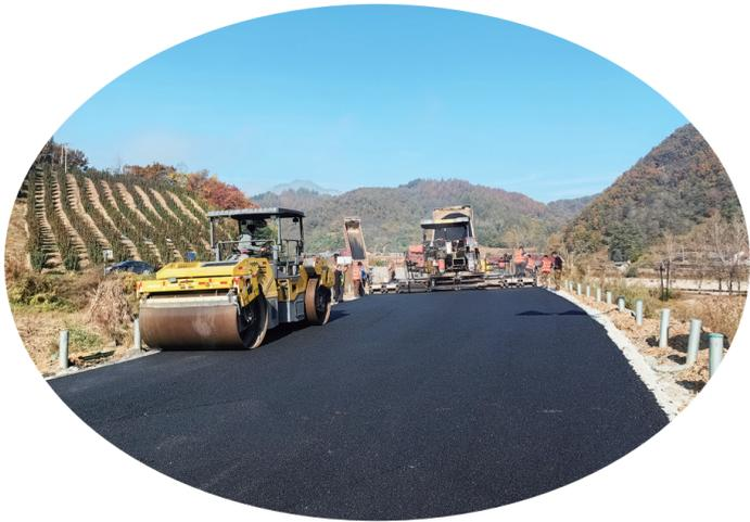
G331通化集安市境内段路面改造工程沥青混凝土路面施工现场。
