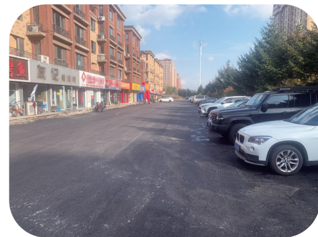
正大清丰园小区前道路翻修一新。
