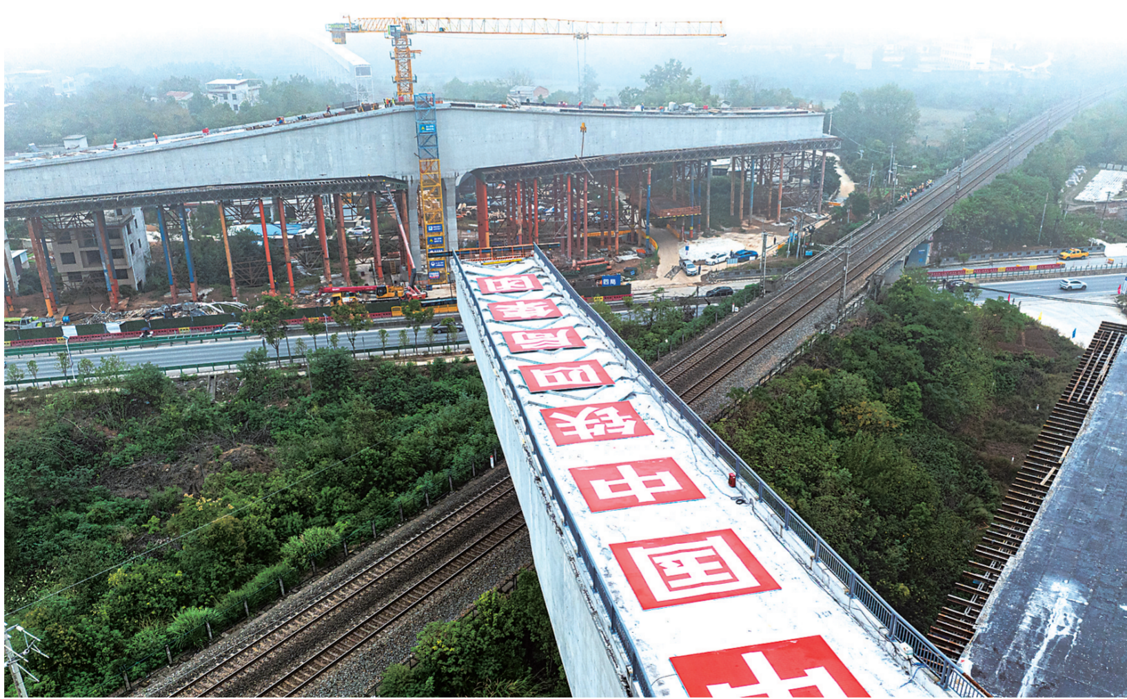
10月23日拍摄的湖北蕲春长岭大道跨京九铁路连续梁转体作业现场(无人机照片)。当日,由中铁四局承建的湖北省蕲春县长岭大道上跨京九铁路大桥连续梁成功完成转体作业,为项目建成运营奠定基础。据悉,此次转体的连续梁长148米、重达9000吨。 新华社记者 肖艺九 摄
