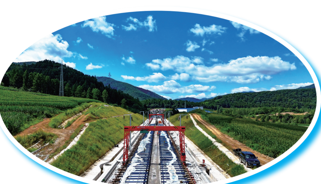
承担沉白高铁吉林段TJ-6标施工任务的中铁二十三局集团沉白高铁项目部，抢抓黄金施工期，开展“百日攻坚会战”劳动竞赛，在长白山脚下吹响大干快上“集结号”，向全面完成年度施工任务目标发起冲击。
