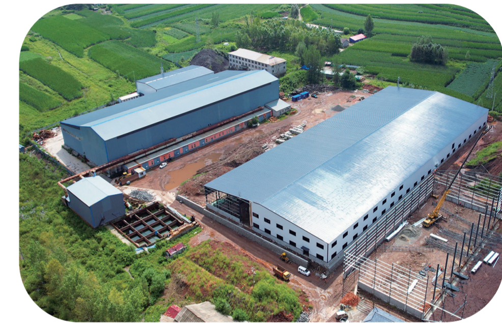
白山市浑江区以三个千亿级产业集群为主攻方向,结合全区现有产业项目计划安排,着力构建高质量产业格局。图为三和静脉产业园加紧建设。
