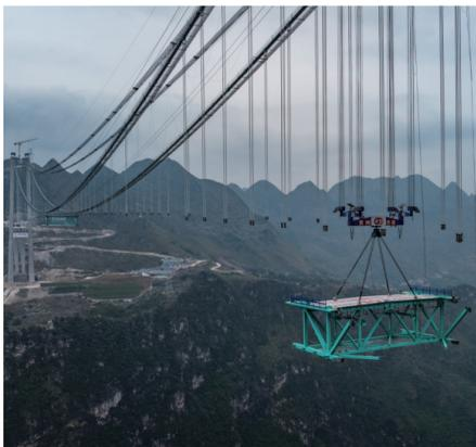
花江峡谷大桥的首件钢桁梁在吊装运输中(11月4日摄，无人机航拍)。11月4日，在建世界最高桥——贵州花江峡谷大桥建设取得重要进展：随着缆索吊机将重约215吨的首件钢桁梁精准吊装至指定位置，大桥施工进入新阶段，为明年通车运营奠定了基础。2022年开工建设的花江峡谷大桥，桥面距水面垂直高度625米，建成后将成为新的世界第一高桥。新华社记者 陶亮 摄
