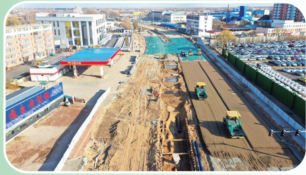
持续推进道路建设。
