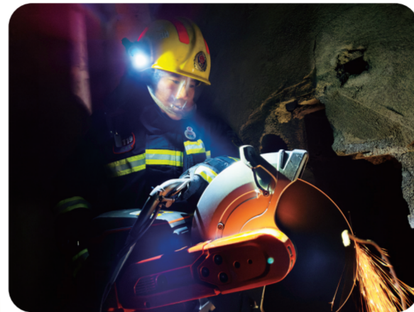
蔚国强正在废墟中破拆搜救被困人员。
