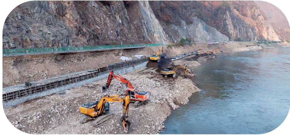
G331水毁重建现场。
