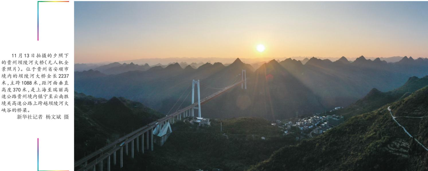
11月13日拍摄的夕照下的贵州兴河大桥（无人机全景照片）。位于贵州省安顺市境内的兴河大桥全长2237米，主跨1088米，距河面垂直高度370米，是上海至瑞丽高速公路贵州境内镇宁至云南胜境关高速公路上跨越兴河大峡谷的桥梁。
