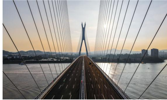
这是11月21日拍摄的富龙西江特大桥(无人机照片)。由中交路建承建的富龙西江特大桥将于11月22日通车。富龙西江特大桥西起佛山高明区，东至佛山三水区，全长1770.6米，主桥为双塔双索面组合梁斜拉桥。通车后，将进一步完善广佛西部片区综合交通体系，推进西江两岸城市联通发展。
