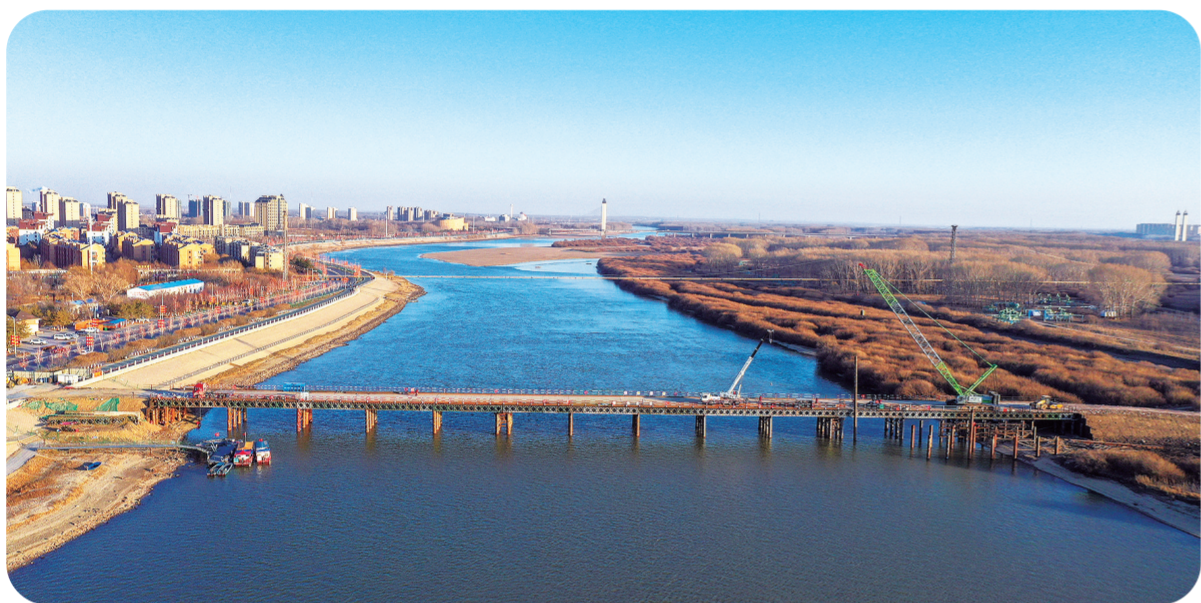
松原市热电清洁供热基础设施建设项目新建DN1200过江供热管道桥项目，承担松原热力有限责任公司江北区域的全部供热负荷。管线桥建成后，下层敷设管道，上层兼做慢行通道，可对松原过江公路桥的行人进行有效分流，桥上可俯瞰松花江美景，改善行人过江体验，同时为松原市新增一处地标性建筑。
