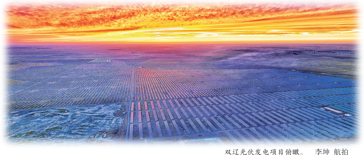
双辽光伏发电项目俯瞰。李坤 航拍
