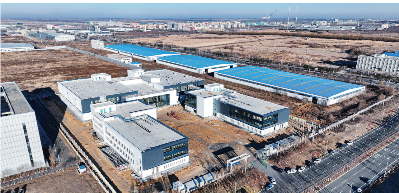
日前，长春新区人工智能新基建(智算中心)项目正有序推进，现正在进行楼体外墙幕墙及水电气等附属工程的施工。该项目计划总投资8亿元，占地面积3万平方米，总建筑面积3.37万平方米，主要建设和运营人工智能平台、智算系统、存储中心等。本报记者 潘硕 摄
