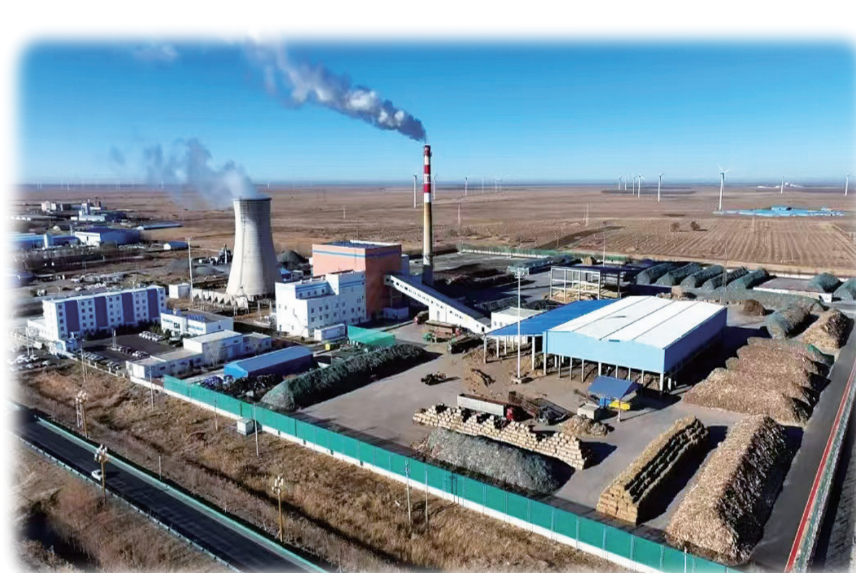
长岭县国能生物发电有限公司生物发电项目。(本版图片为资料图片)
