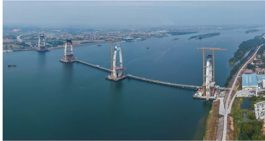
这是12月25日拍摄的清花高速北江特大桥封顶的主塔(右二)(无人机照片)。当日,由广东交通集团投资、中铁大桥局承建的清(清远清新)花(广州花都)高速公路北江特大桥首个主塔封顶。
