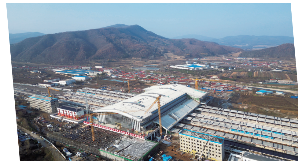
通化加速迈入“高铁时代”。图为建设中的通化西站项目。(资料图片)本报记者 孙鑫 摄
