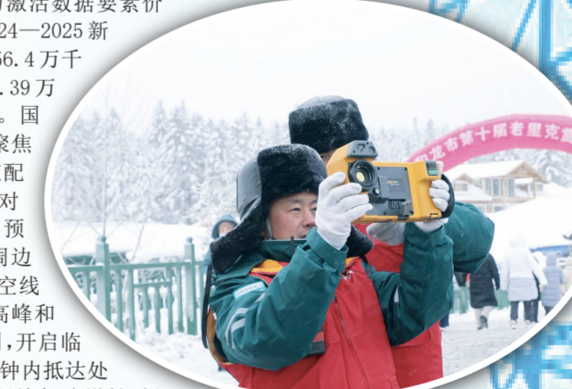
国网吉林电力工作人员在和龙市老里克湖景区检查供电线路,确保冰雪节圆满开幕。孙菲 摄
