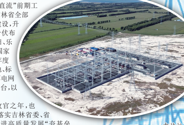
吉林松原布苏500千伏变电站扩建工程。贾正 摄
