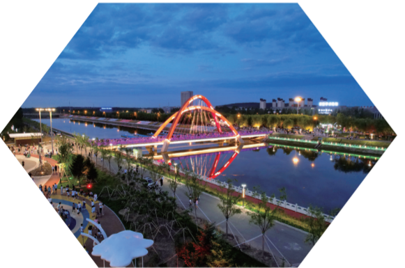
大力推进城市更新,建设更具品质的魅力城区。曲袖玮 摄
