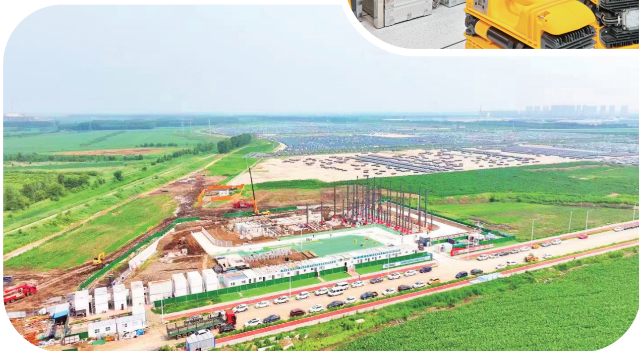
▼前程220千伏变电站建设现场。
