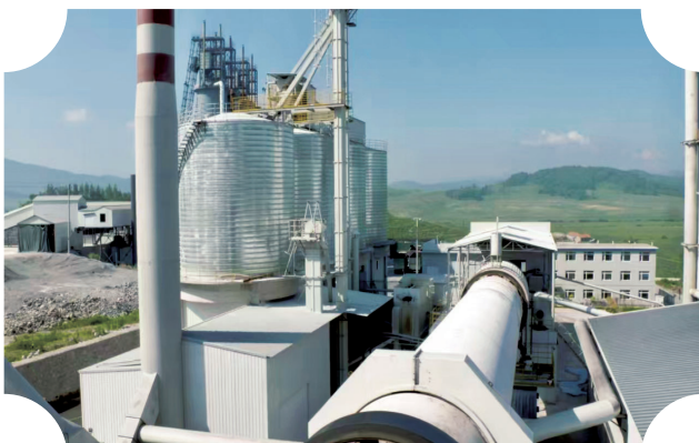
桦甸市汇金钙业有限公司回转窑外景图。
