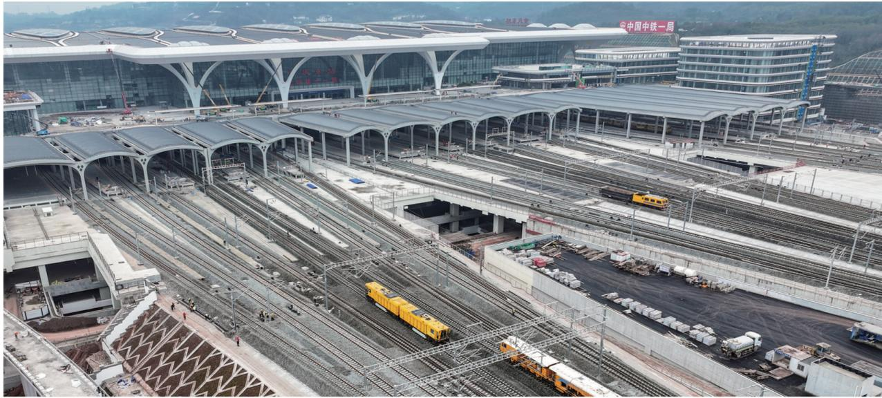
这是2月18日拍摄的重庆东站建设施工现场线路精调作业现场(无人机照片)。当日，中铁十一局、成都铁路局重庆工务段的工人在大型机械的协助下，在重庆东站建设施工现场进行轨道铺设完毕后的精调工作。重庆东站建成后将成为我国西部地区最大的高铁枢纽站，助力成渝双城经济圈及西部陆海新通道建设。
