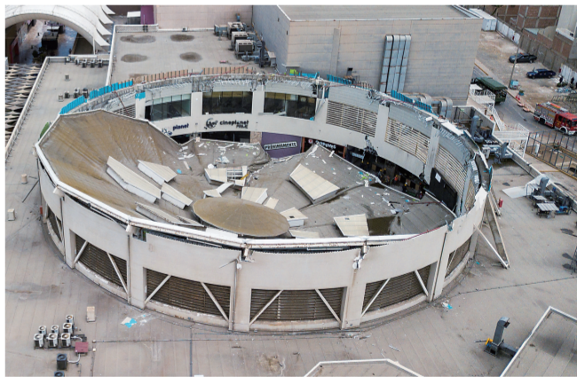
这是2月22日在智利特鲁希略市拍摄的购物中心坍塌事故现场(无人机照片)。据智利内政部22日说，特鲁希略市购物中心屋顶坍塌事故死亡人数已升至8人，其中包括3名未成年人，另有80余人受伤。新华社/路透
