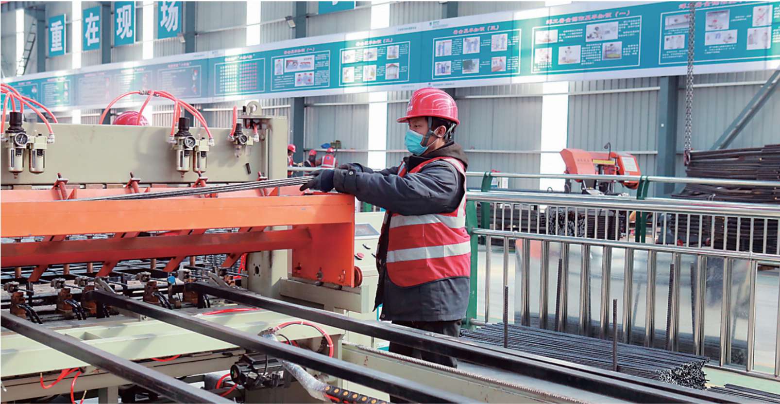
连日来，国网新源吉林蛟河抽水蓄能电站项目正紧张有序推进。该项目是国家“十四五”规划重点能源项目，投运后将承担东北电网调峰、填谷、调频、调相及紧急事故备用等任务，有效缓解吉林电网调峰压力，提高风电等消纳能力。
