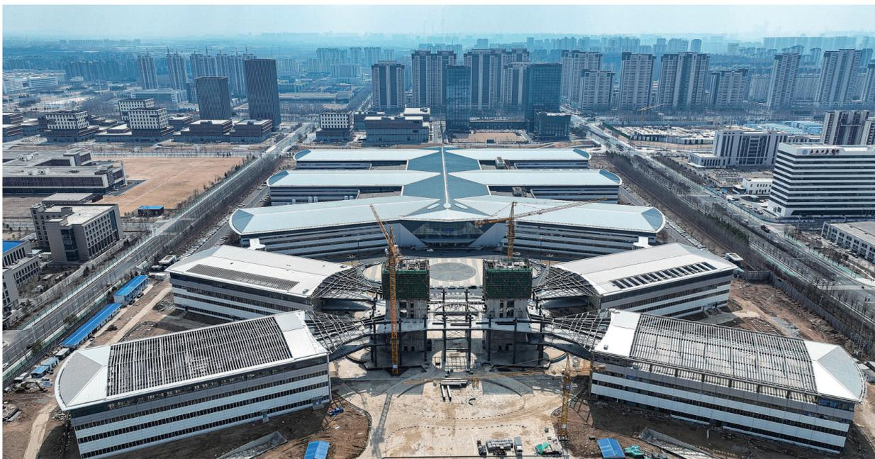
连日来,长春新区长光卫星航天信息产业园二期项目建设稳步推进。目前,遥感数据大厦核心筒结构施工快速推进,数据机房楼等四栋裙楼结构施工已全部完工。按照建设规划,项目预计今年底实现主体封顶。
