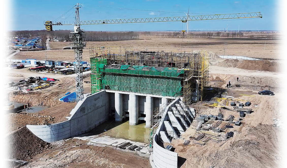
在大安市两家子镇同安村的小西米泵站,各项施工有序推进。(大安市委宣传提供)
