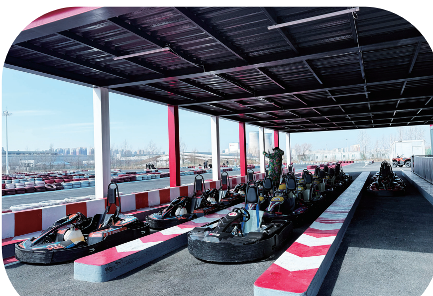
吉林朱雀国际赛车运动公园陆续开展二期项目建设。冯荟羽 摄
