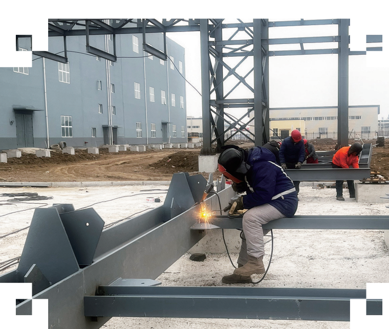
位于吉林经开区的常丰化学(吉林)有限公司年产6.38万吨农药项目一期已经开始设备安装。张添奥 摄
