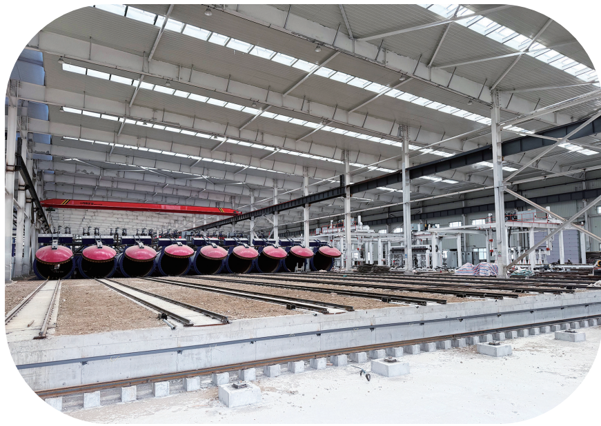
位于永吉县的中泽钼尾矿综合利用二期项目施工现场。冯荟羽 摄
