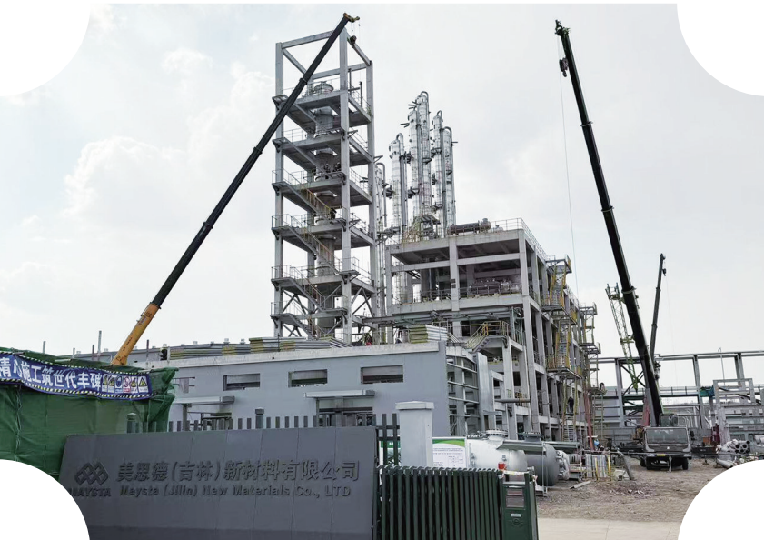
位于龙潭区的美思德(吉林)新材料有限公司年产8000吨二甘醇胺产吗啡装置正在进行设备安装。周瀚宇 摄
