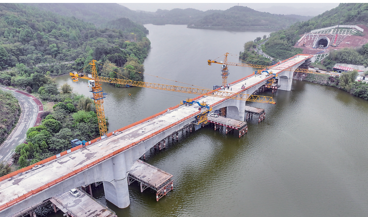
这是4月12日拍摄的合龙后的成渝中线高铁玄天湖双线大桥（无人机照片）。4月12日，由中铁五局承建的成渝中线高铁全线控制性工程玄天湖双线大桥顺利合龙。玄天湖双线大桥全长460.561米，位于重庆市铜梁区玄天湖4A级景区内，环保要求高，施工难度大。新华社记者 唐奕 摄
