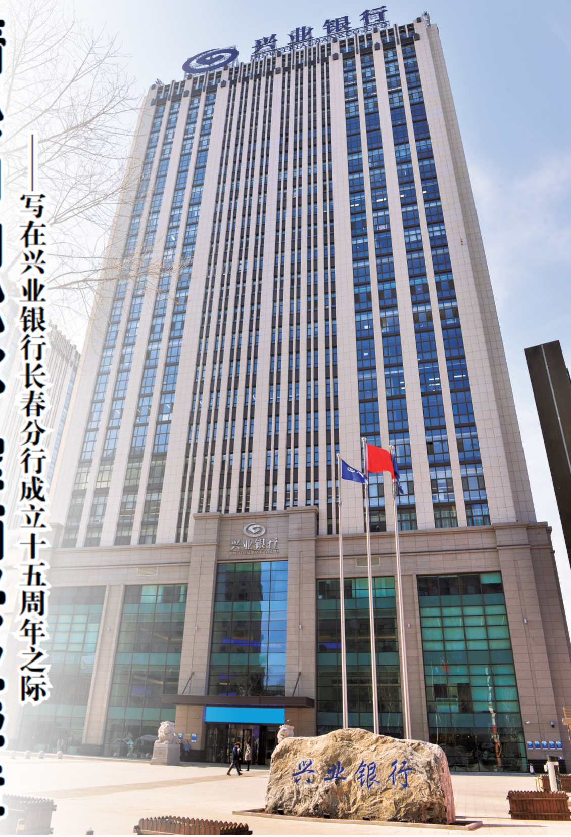
兴业银行长春分行办公大楼。
