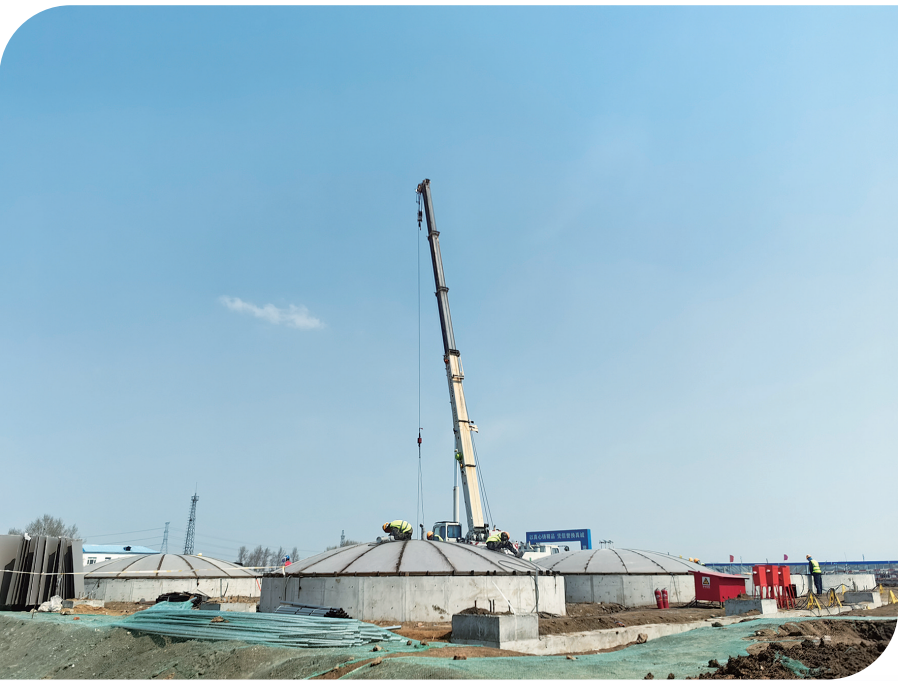
中粮油脂长春油料加工项目建设现场。
