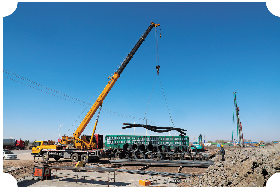
中车松原新能源装备产业园区叶片二期项目。
