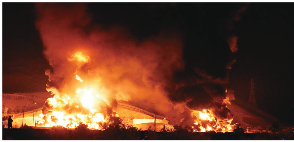
这是6月15日凌晨拍摄的伊朗首都德黑兰附近遭以色列袭击起火的储油设施。新华社/美联
