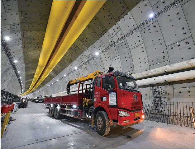
6月22日,施工车辆在济南市黄岗路穿黄隧道内行驶。当日,山东省济南市黄岗路穿黄隧道顺利完成黄河段掘进任务,这一世界最大直径水下盾构隧道工程建设取得阶段性突破。济南市黄岗路穿黄隧道全长约5755米,其中盾构段长约3290米,盾构机开挖直径17.5米,是目前在建的世界最大直径水下盾构隧道。 新华社记者 徐速绘 摄
