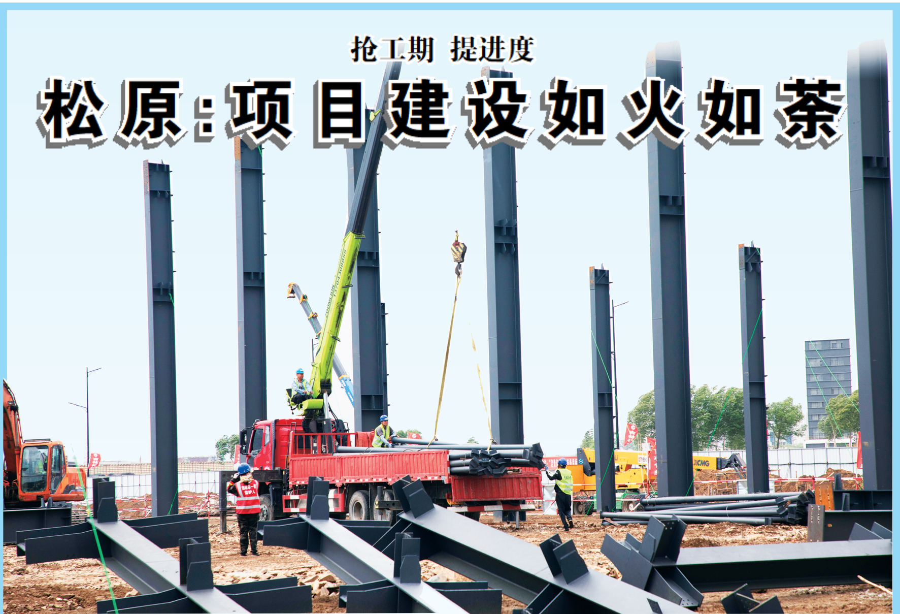
吉林化纤年产6600吨碳纤维热场材料项目建设现场。
