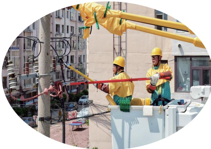
近日,国网吉林供电公司带电作业中心刘卫立和同事在10千伏康庄乙线安全分线8右2号杆进行更换跌落式开关作业。王雨欣 摄
