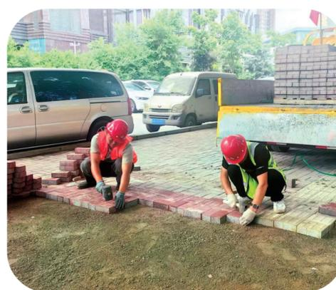
轨道交通3号线世纪广场站轻轨桥下正在进行步行方砖铺设。
