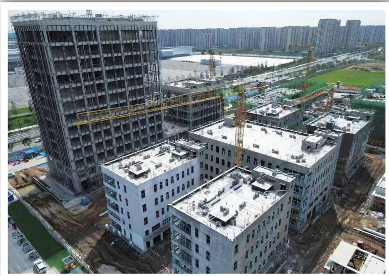
长春永春医药城孵化创新中心项目主体结构已完成。
