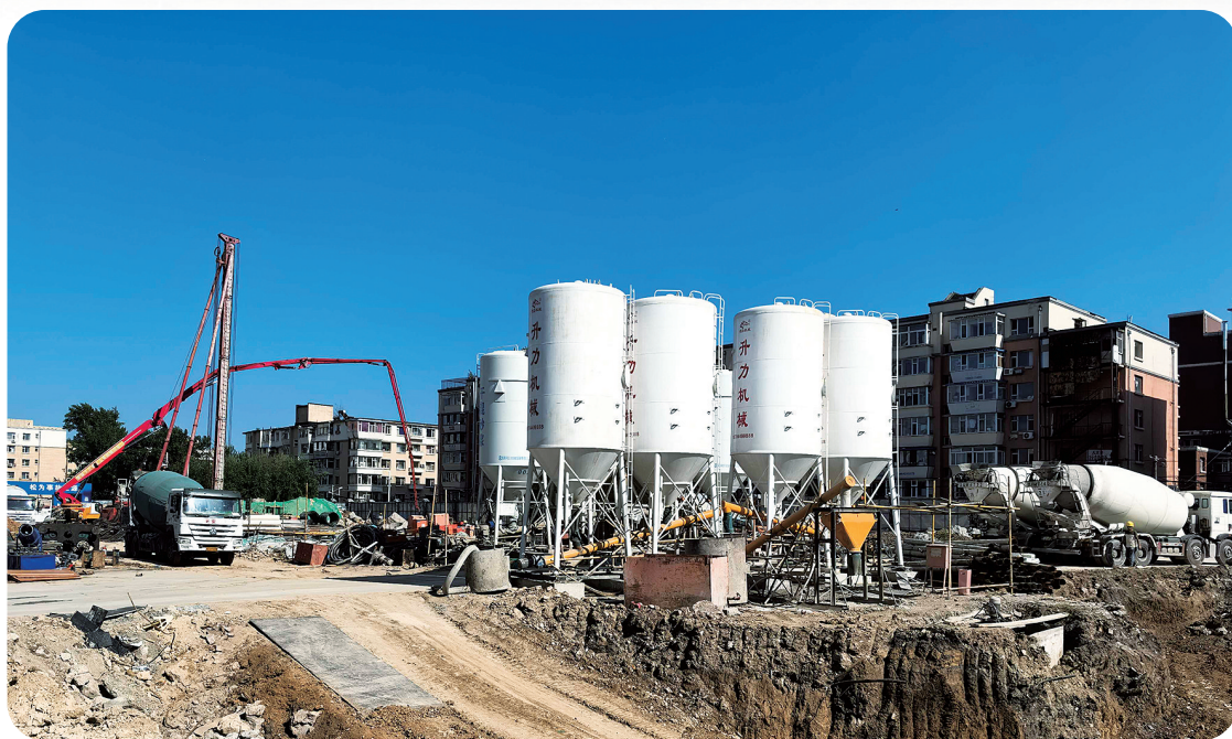
项目建设现场忙而有序。
