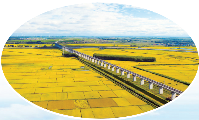
以“藏粮于地、藏粮于技”为战略指引,政策扶持与科技赋能双管齐下,松原市多方位筑牢粮食安全屏障。图为松原灌区。
