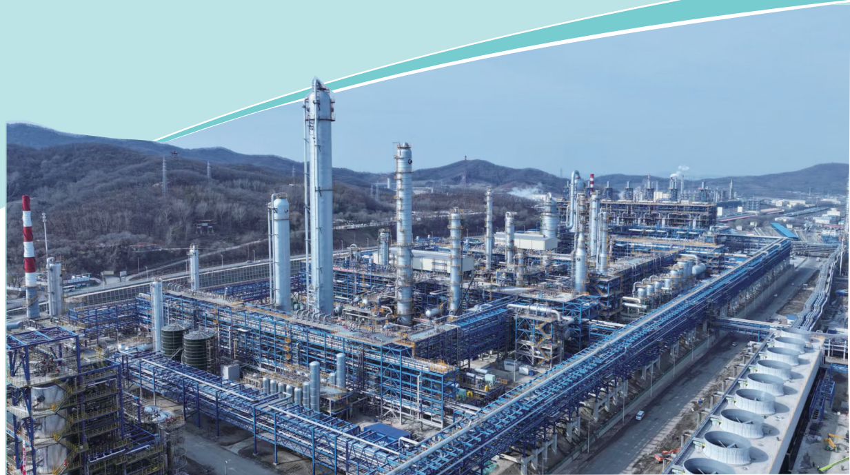
吉林石化转型升级项目年产120万吨乙烯装置实现中交后俯瞰场景。
