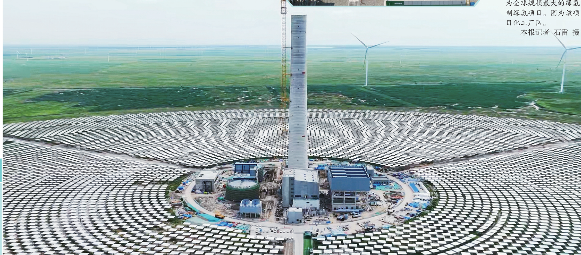
中广核吉西基地鲁固直直流10万千瓦光热项目全体建设者正全力以赴,向着年底并网发电目标前进。
