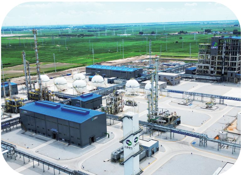
7月15日,上海电气洮南绿色甲醇项目投产,该项目是行业内首次实现风电制氢与生物质气化耦合大规模生产绿色甲醇的具体实践,标志着我国在绿色氢基燃料领域取得重大突破。 张磊 摄
