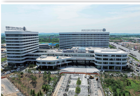
公主岭市中心医院新址(吉林大学白求恩第三医院公主岭医院)。
