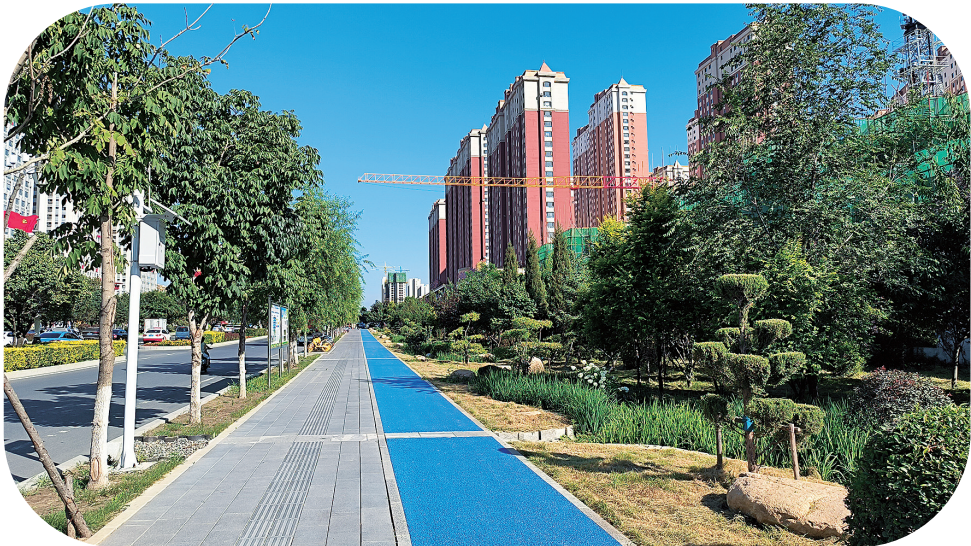
四平紫气大路海绵城市建设项目一角。
