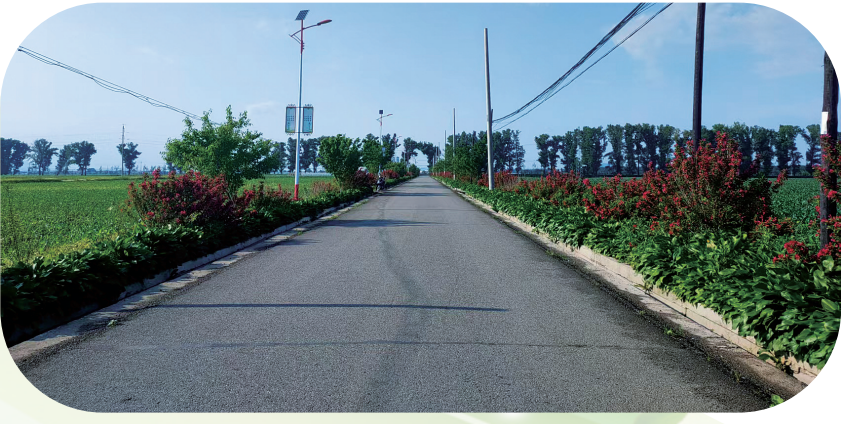
龙潭区全力推进净美村庄建设。
