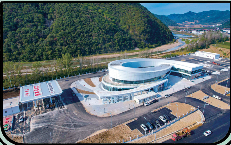
中国铁建大桥局承建的G331项目吉林段太极湾旅游驿站，“神鸟腾飞”造型。
