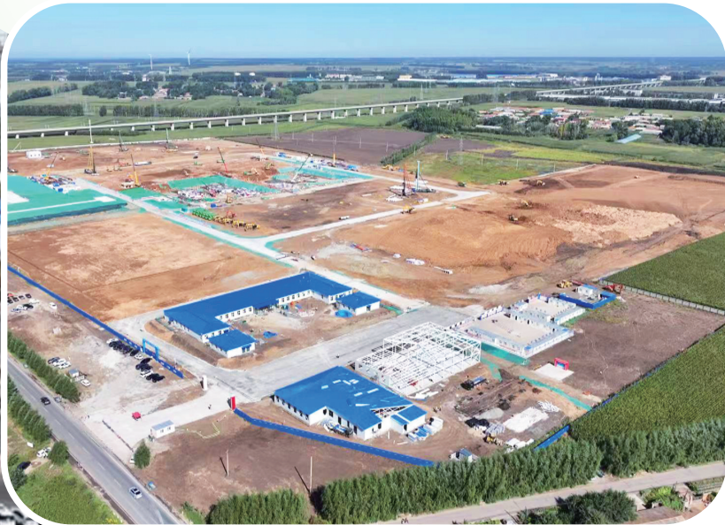
大唐长春二热“退城进郊”2×660兆瓦煤电项目施工现场。
