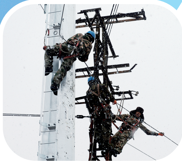
国网白山供电公司迁改10千伏湾沟线16号杆。
