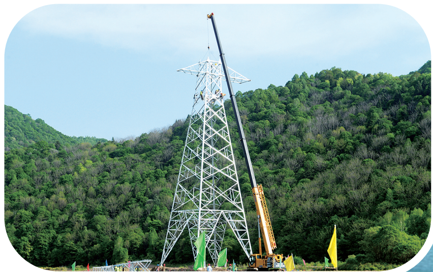
国网白山供电公司建设220千伏湾江线4号塔。
