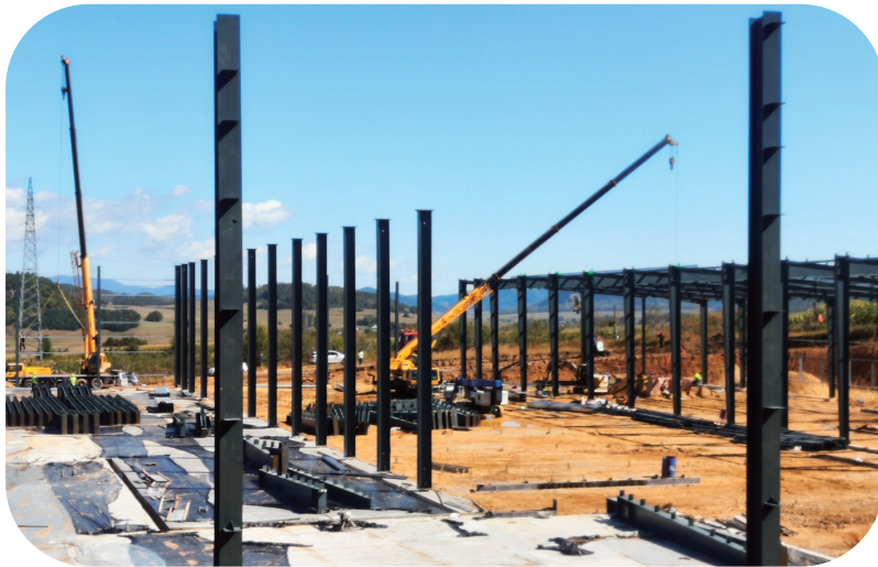
年产10万吨桦甸白桦树汁产业园项目现场。
