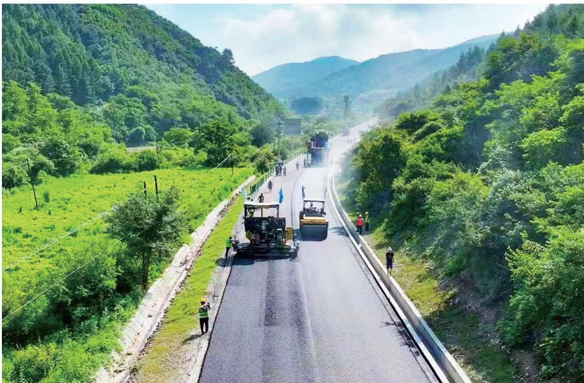
为季冻区公路量身打造抗严寒“路面配方”，破解了低温冻胀、融沉开裂的养护难题。
