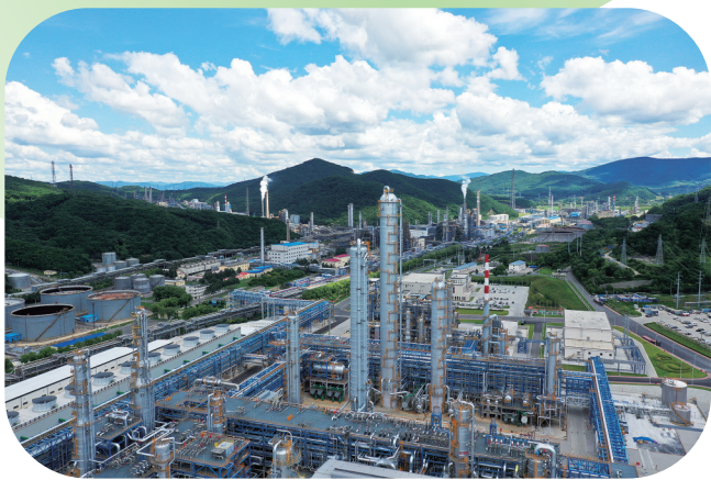
吉林石化年产120万吨乙烯项目现场。
